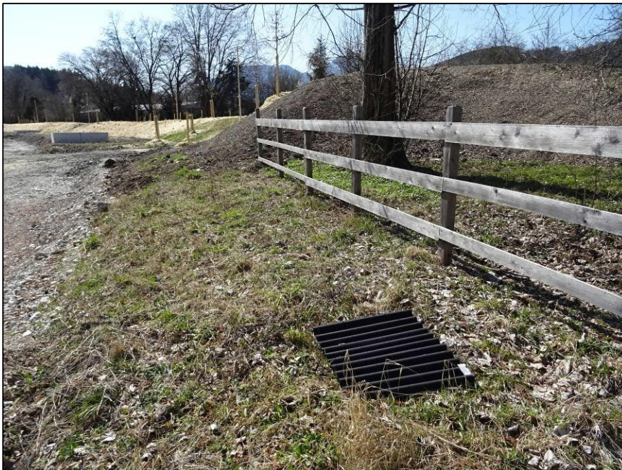
Abbildung 25 Bitumenwellpappe am Rand des Altbaumbestandes im nördl. UG (April 2021)
