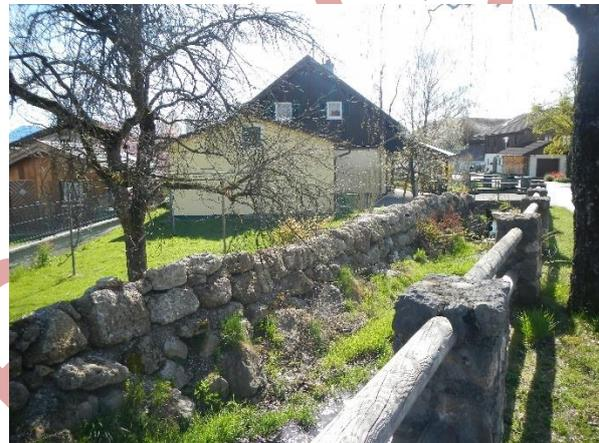
Abbildung 1.6: Ausgebauter Abflussquerschnitts des Mühlstätter Grabens 4 (aquasoli 2022a)
