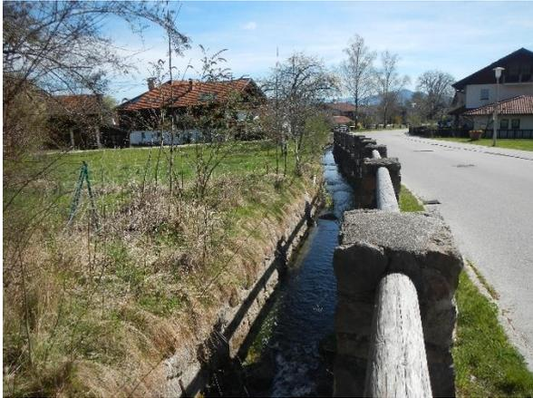
Abbildung 1.3: Ausgebauter Abflussquerschnitts des Mühlstätter Grabens 1 (aquasoli 2022a)
