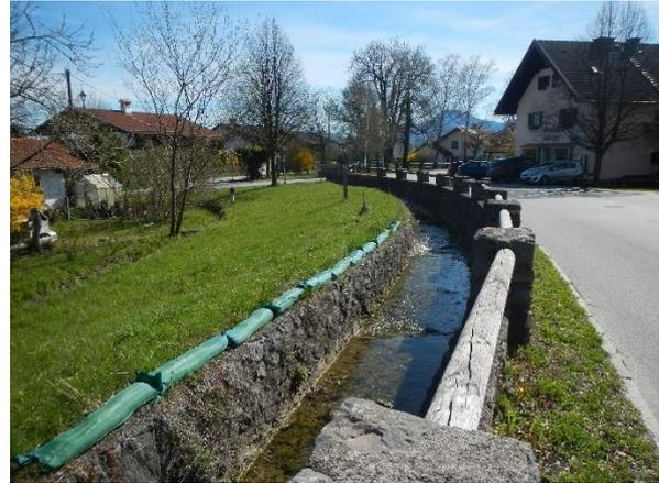
Abbildung 1.4: Ausgebauter Abflussquerschnitts des Mühlstätter Grabens 2 (aquasoli 2022a)
